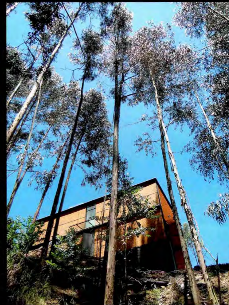
CASA SAMANIEGO. Vista desde quebrada
