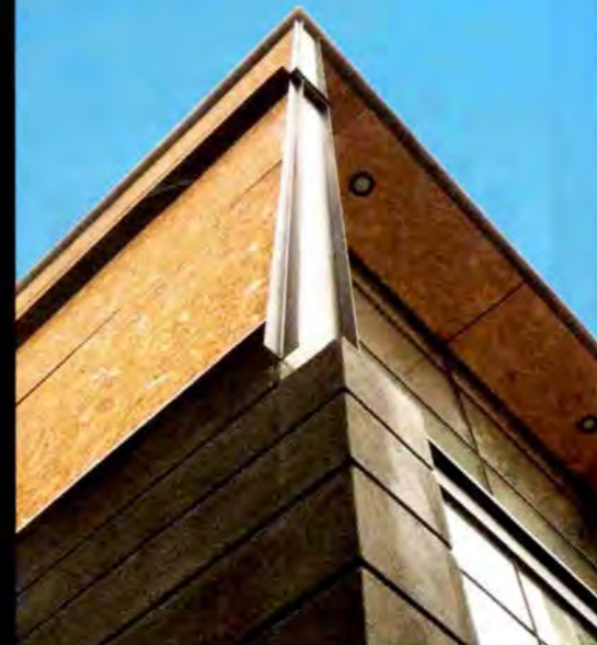
CASA SAMANIEGO. Vista detalle
